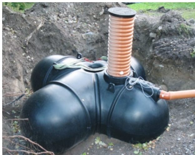
Installation av Wavin slutna tank 3000 I PE
