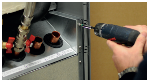
3. Skruva bort kylmodulens fästsruvar.
