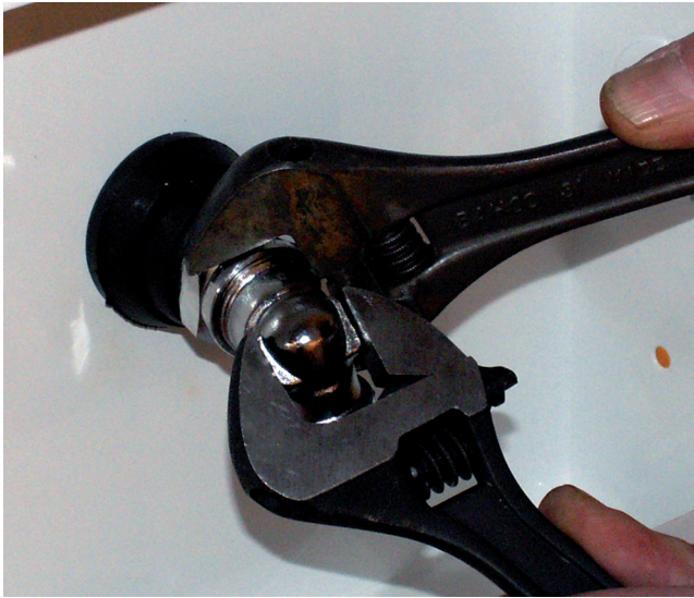
5. Montera vattenutkastarens vinkelkoppling på kopparröret.
