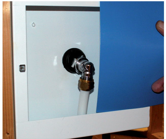
8. Montera de medföljande sprutskydden.
