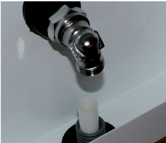
6. För genom LK:s Universalrör (RiR) in i skåpet samt montera den andra medlevererade skåpsgenomföring UNI.
