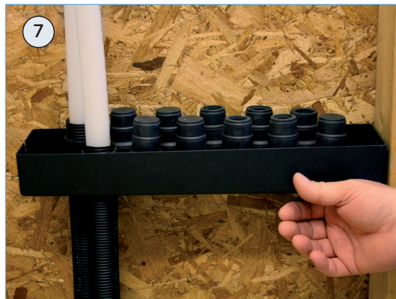
7 Trä matningsledningen och skyddsroret genom gum-migenomföringen. Skyddsroret ska åtminstone vara i nivå med den övre trågekanten.
