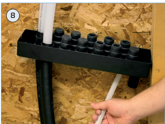
8 Trä in tappvattenrör och skyddsrör i tråget.
