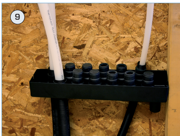
9 Skyddsroret ska åtminstone vara i nivå med den övre trågekanten. Utsticket på röret ska vara tillräckligt långt för att kunna anslutas mot Multifördelaren.
